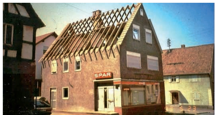
Beginn des Abbruchs Mai 1993
