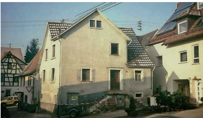
Blick zum Altbau vor Abbruch
