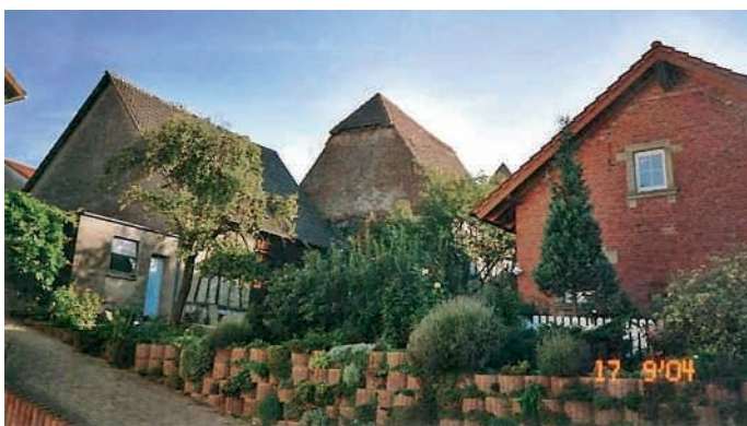
Blick aus der Gartenstraße auf Scheune mit Kuppelwalm, rechts das „Milchhäusle“
