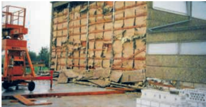
Die alte Ostwand beim Abbruch (Waschbetonplatten und Isolierung)
