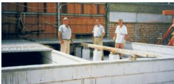
Verlegung der Deckenplatten für den Bühnenboden
