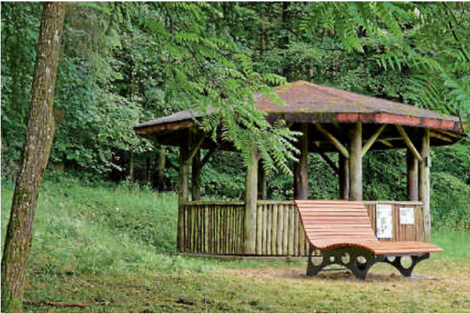
Standort in Hüffenhardt neben dem Pavillon an der Dienernwiese
